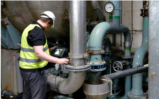
Inspección de tubería industrial con Proceq Flaw Detector 100
